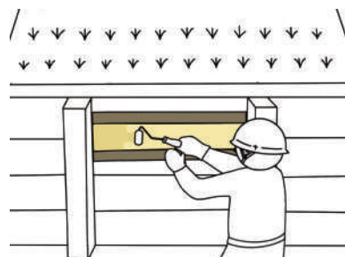
10. 乾燥後2回目塗布します。
