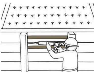
6. 継ぎ目にシール材を充填します。
