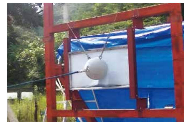
SPシート施工後
