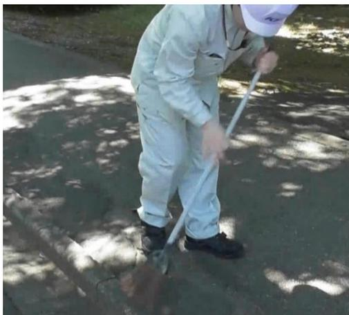
写真-2 施工面の清掃
