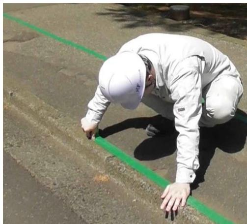
写真-3 施工面の養生
