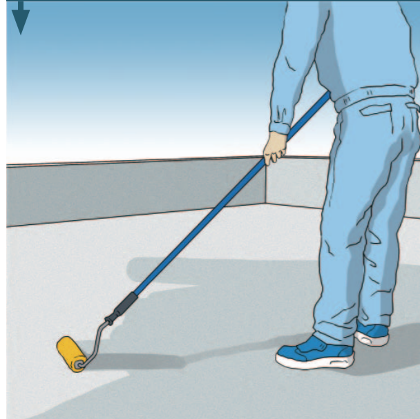
① プライマー塗布
