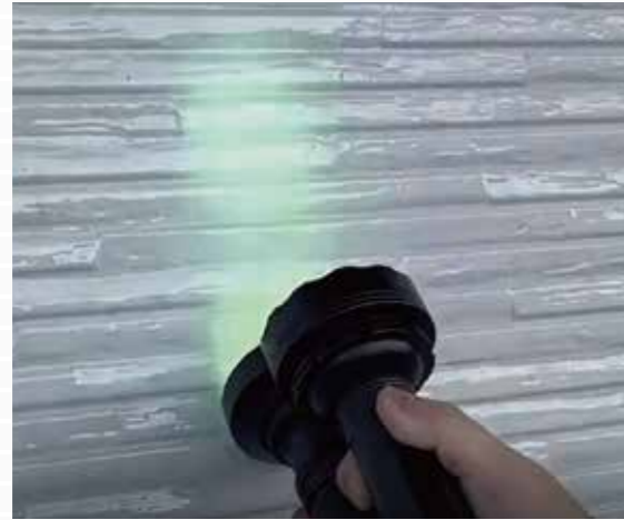
ブラックライトで塗布状態を瞬時にチェック 推奨：ブラックライト 100LED型
